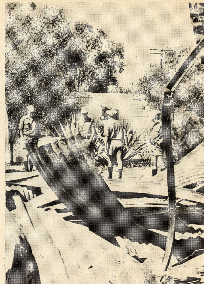
Ennen tässä oli sairaala, nyt vain betonipäädyt, vääntynyttä rautaa ja tuhkaa. Sairaala sai osuman ja paloi romukasaksi, onneksi potilaat olivat jo aikaisemmin siirtyneet suojapoterioihin.
